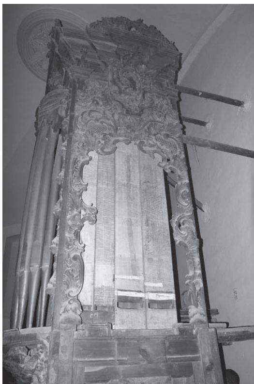
FIG. 3. Lateral del órgano con los conductos de aire recubiertos de documentación de archivo. Antonio Martín Pradas (AMP).
